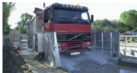
Lavage des pneus pour éviter la formation de boues
